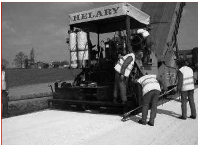
Photo 10 : Mise en œuvre des tous premiers enrobés au liant végétal (couleur blanche).
