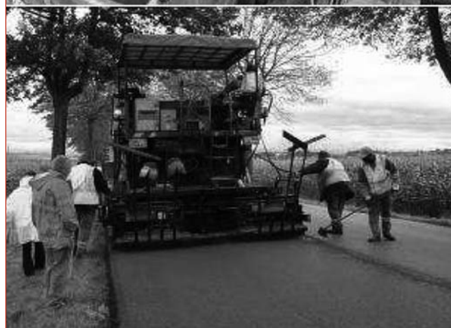
Photos 8 et 9 : Chargement d'un camion à la centrale de fabrication mise en œuvre des enrobés correspondants sur une route départementale très circulée.
