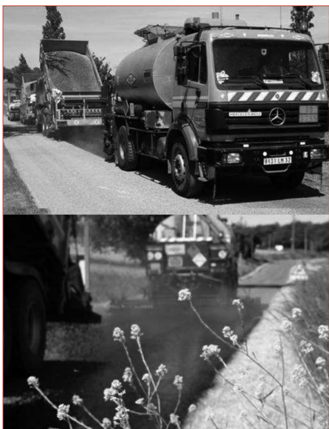
Photos 2-3 : Enduit superficiel appliqué dans le Gers en octobre 2005.
