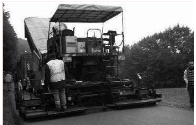
Photo 11 : Octobre 2003, mise en œuvre des enrobés 0/6 à Ligsdorf.
